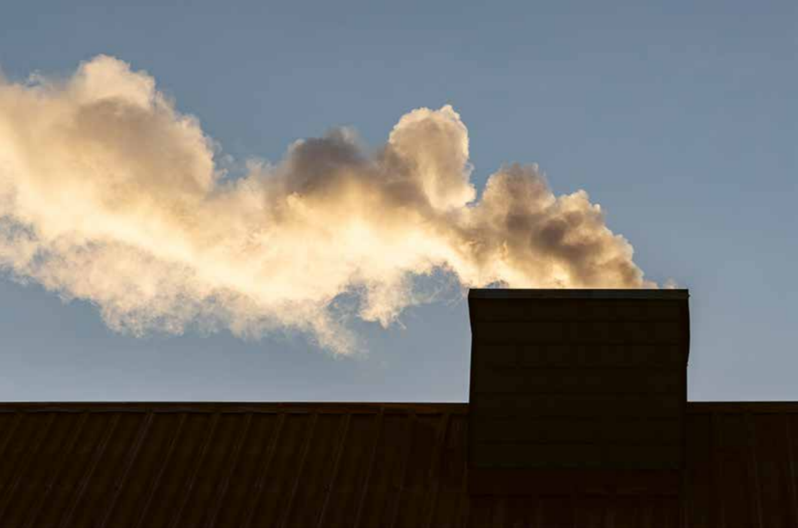
Die fossile Wärmeversorgung erzeugt den Hauptanteil der Treibhausgasemissionen im Gebäudebereich. Dessen Ausstoss nimmt allerdings ab. (Foto: DK-Fotowelt / Adobe Stock)
