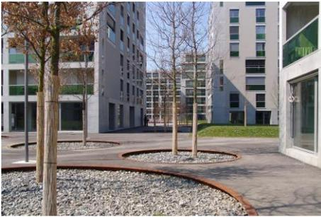
Die 2007 erbauten sieben kompakten, fast würfelförmigen Gebäude haben acht Geschosse und je ein Untergeschoss. Die Fassaden der Erdgeschoss, Gebäudekanten und Loggien sind mit robusten Betonelementen gefasst, die flächigen Teile als Kompaktfassaden ausgeführt.
