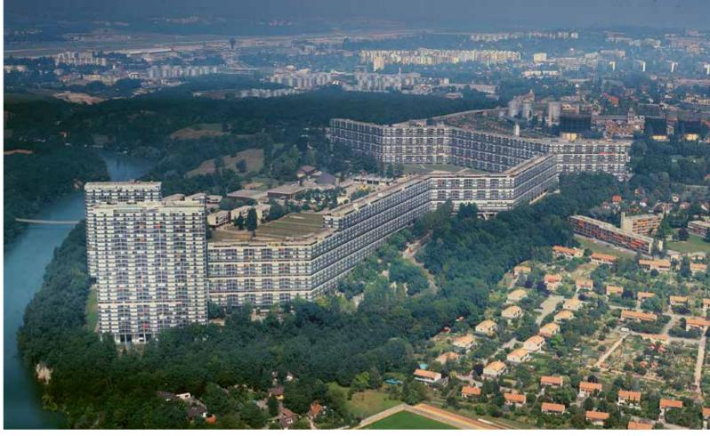
tätigkeit intensivieren konnte. Das waren aber nicht immer Fachkräfte, sodass sich die Frage stellte, wie man mit weniger gut ausgebildeten Arbeitern mehr Wohnungen produzieren konnte. «Eine der Antworten darauf war das modulare Bauen mit vorgefertigten Betonelementen für den Rohbau, das vor allem ab Mitte der 1960er-Jahre einen starken Aufschwung erlebte», erklärt der Historiker Fabian Furter, der sich für seine Dissertation intensiv mit dieser Phase beschäftigte (siehe Infobox).
