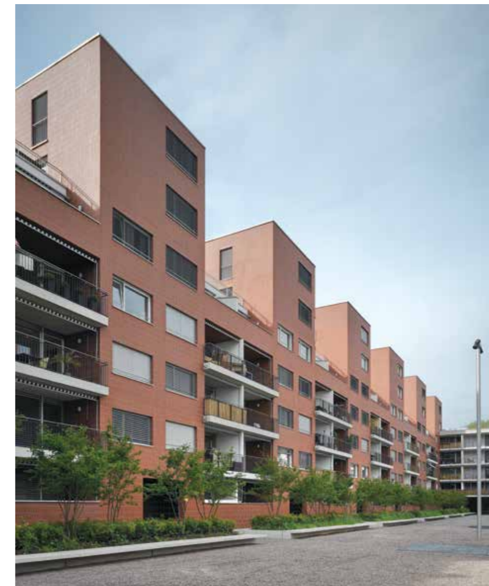
Das Zwicky-Areal in Wallisellen mit Klinkerfassade.
