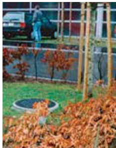
Bild 4-36: Schlecht platzierte Aussenluftfassung
