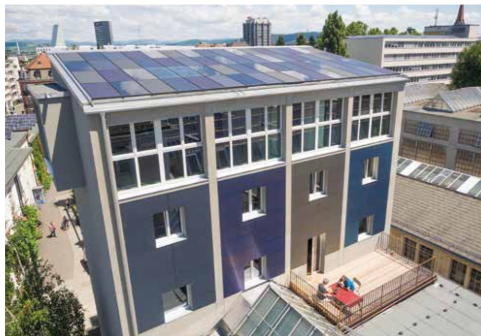
Abbildung 6: Mehrzweckgebäude «Kohlesilo» in Basel ist einer der Preisträger des Schweizer Solarpreises 2015 (Quelle: Solvatec).
