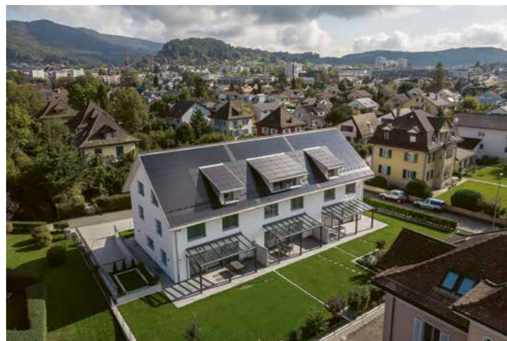
Bild 2.2: Das einzige mengenmässig nicht limitierte Fördermodell von Solarstrom in der Schweiz ist der Eigenverbrauch. In Form eines ZEV ist er beispielsweise bei Wohnbauten zunehmend beliebt. (Foto: Helion – Bouygues E&S Intec Schweiz AG)
