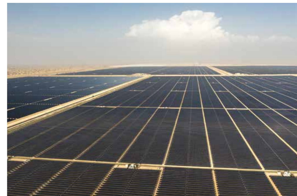
Bild 2.3: Grossanlagen werden oft mit wettbewerblich ausgeschrieben Power Purchase Agreements (PPA) gebaut. (Foto: kertu_ee via iStock)
