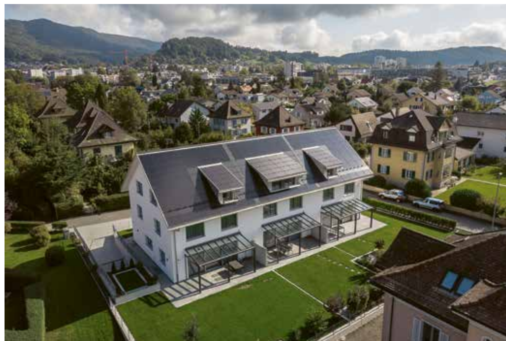
Figure 2.2: La consommation propre est le seul modèle de promotion de l'électricité solaire en Suisse qui ne soit pas limité en termes de quantité. Sous la forme d'un RCP, elle est, par exemple, de plus en plus appréciée dans les immeubles d'habitation. (Photo: Helion – Bouygues E&S Intec Schweiz AG)
